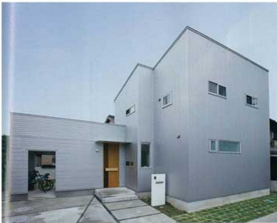
別荘な住宅街で個性を放つガルバリウム鋼板貼りの外観。玄関側には大きな窓を設けてプライバシーに配慮。自転車置き場の上層をロフトにするなど、空間活用にも工夫。「名古屋オフィスオープンを知り、いち早くお訪ねしたのが正解でした」（見開きの写真はすべて愛知県S氏邸）
