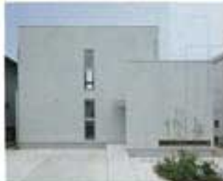
ガルバリウム鋼板の外壁が個性を放つ外観。スリット窓をデザインに活かしてシンプルに
